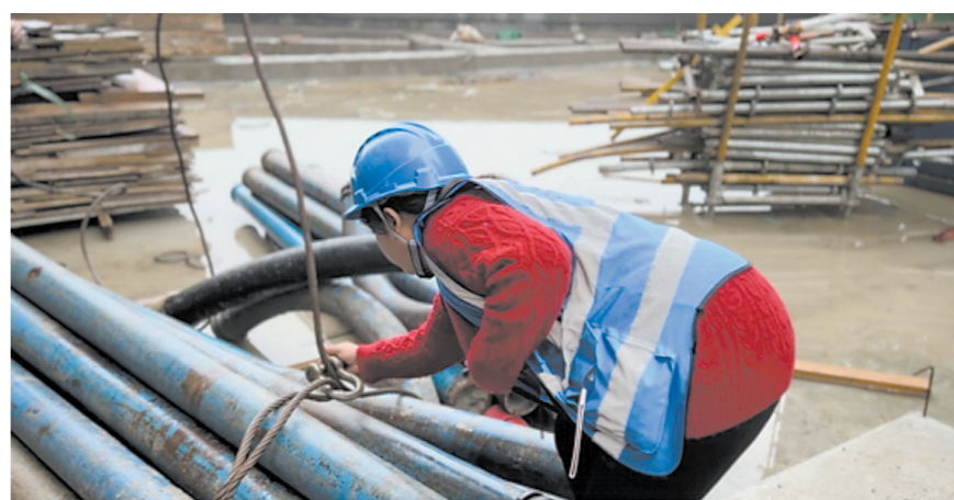
工地女工李七双正在检查挂钩
