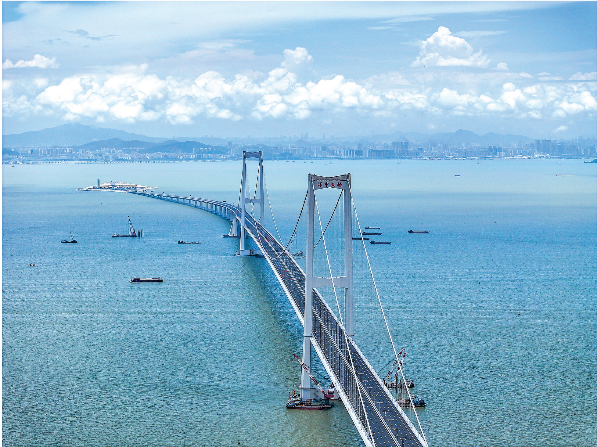
深中大桥是世界最大跨径全离岸海中钢箱梁悬索桥,主跨1666米,主塔高270米,相当于90层楼高,通航净空高度为76.5米,创造了5项世界纪录
