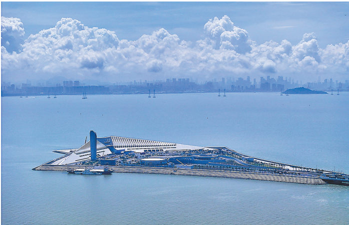
西人工岛是跨海桥梁和海底隧道转换点,岛体采用菱形设计,面积约13.7万平方米,相当于19个足球场那么大
