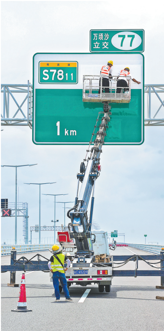
2024年6月12日,工人安装桥面信息指示牌
