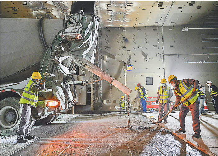
2023年11月28日,深中通道海底隧道最终接头在管内浇筑完成压舱混凝土,由此深中通道主线贯通
