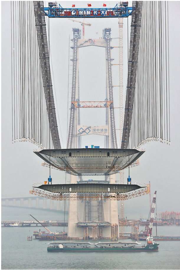
2023年3月12日,深中大桥钢箱梁桥面吊装作业正在施工。钢箱梁单节最大起吊重量约400吨,全桥钢箱梁总重约5.66万吨,相当于北京鸟巢用钢量的1.2倍
