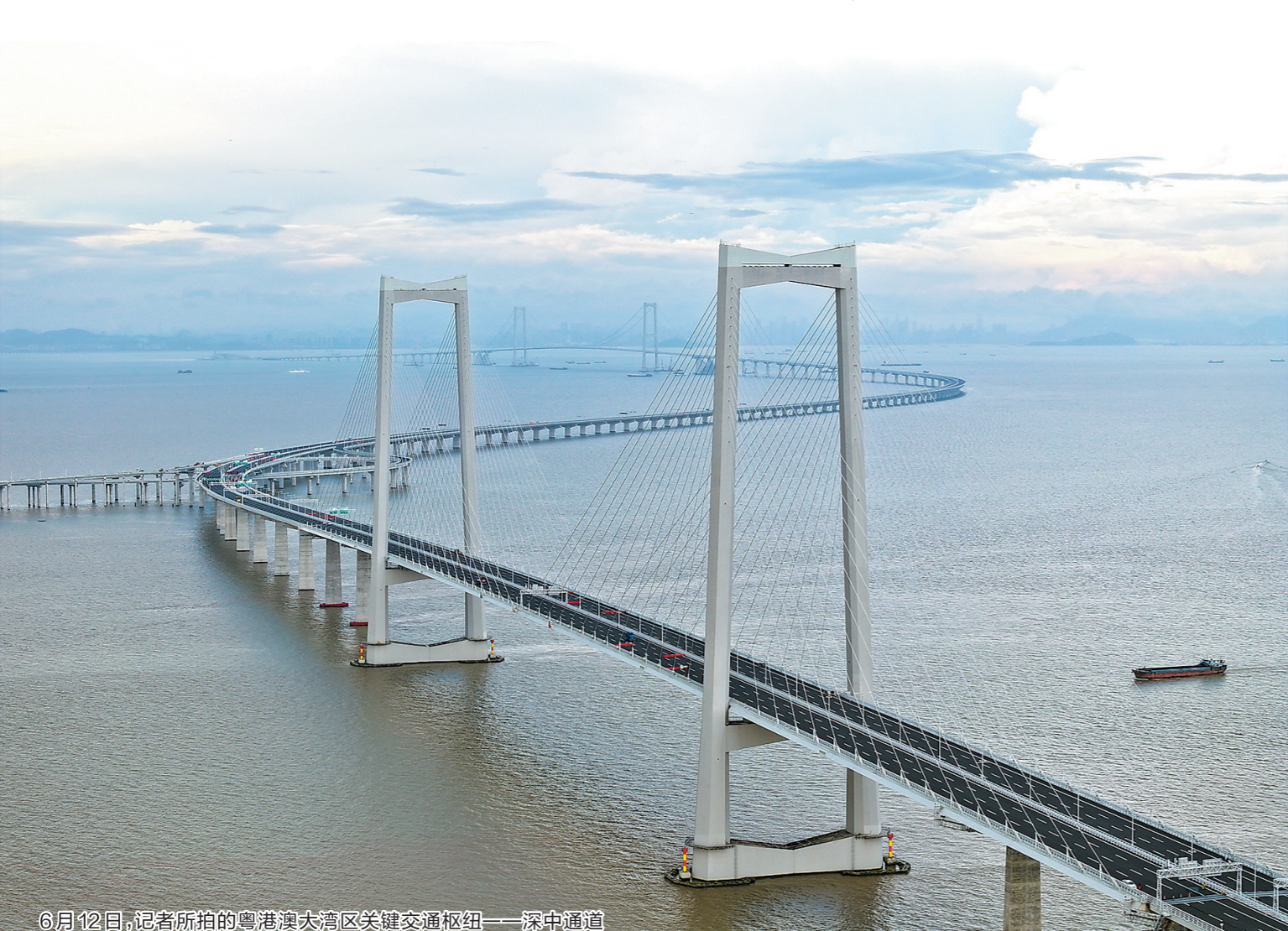
6月12日,记者所拍的粤港澳大湾区关键交通枢纽——深中通道
