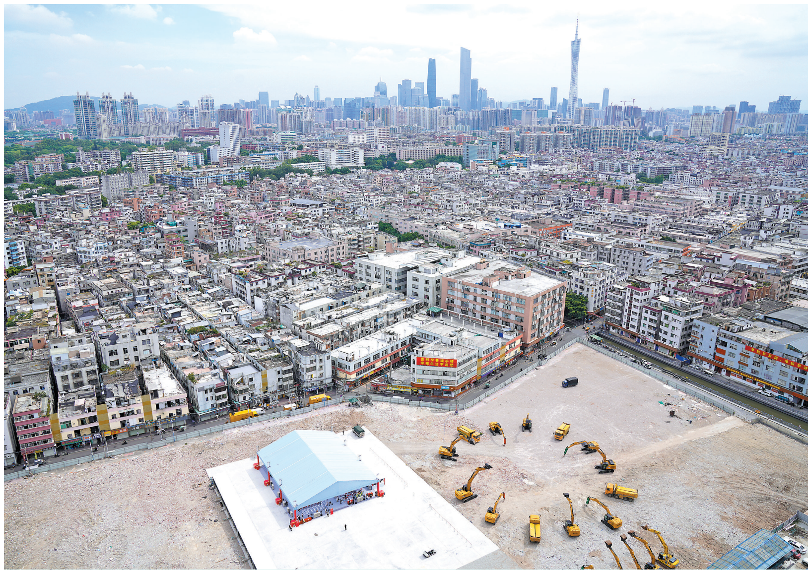
24日，在广州市海珠区康鹭片区城中村改造项目现场，F37、F57两个地块同时破土动工 羊城晚报记者 宋金峪 摄
