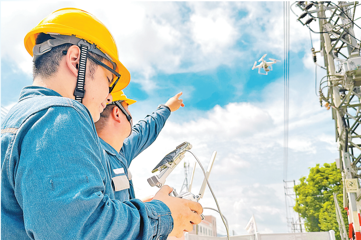
南方电网广东江门供电局智能作业人员对10千伏线路进行精细化巡检，护航迎峰度夏期间线路安全稳定运行
