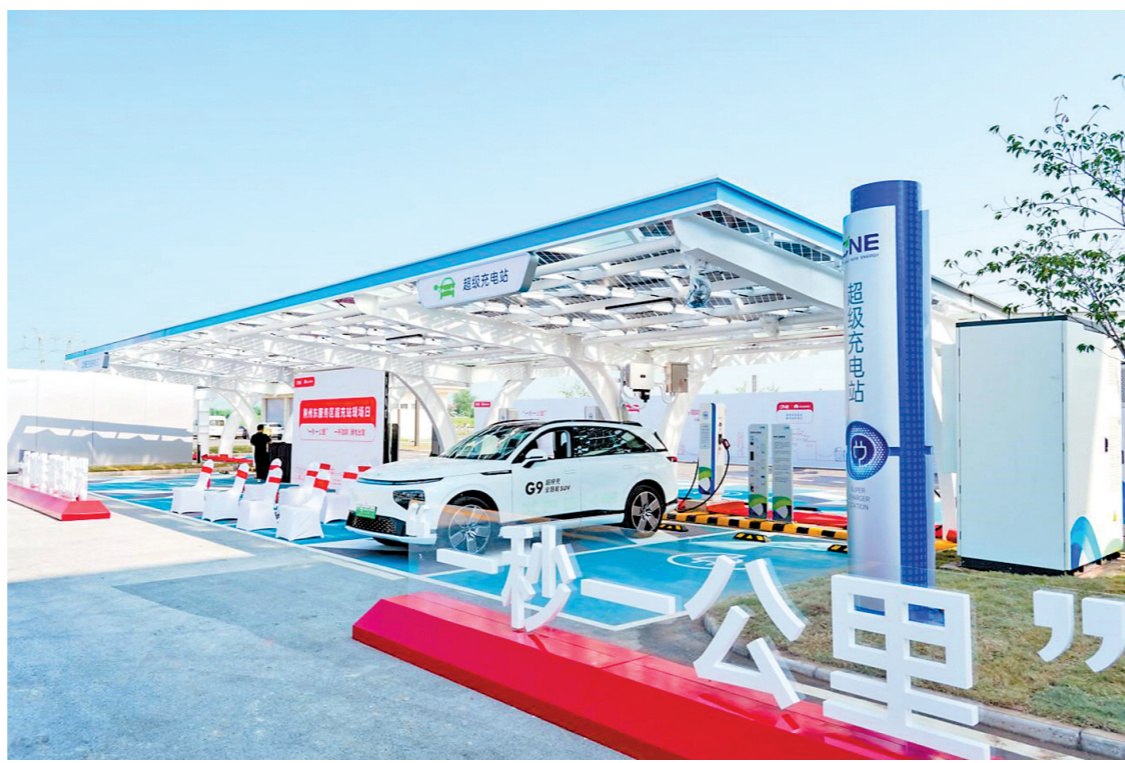
蔚景云高速公路运营站
