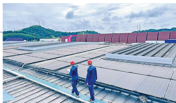
南方电网广东东莞供电局客户经理为中集公司分布式光伏开展新装工程并网验收工作
