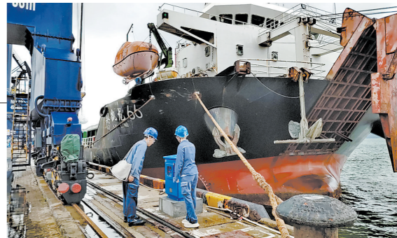
南方电网广东惠州大亚湾供电局工作人员检查港口岸电设施运行情况
