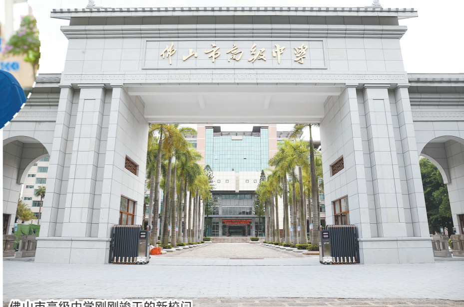
佛山市高级中学刚刚竣工的新校门
