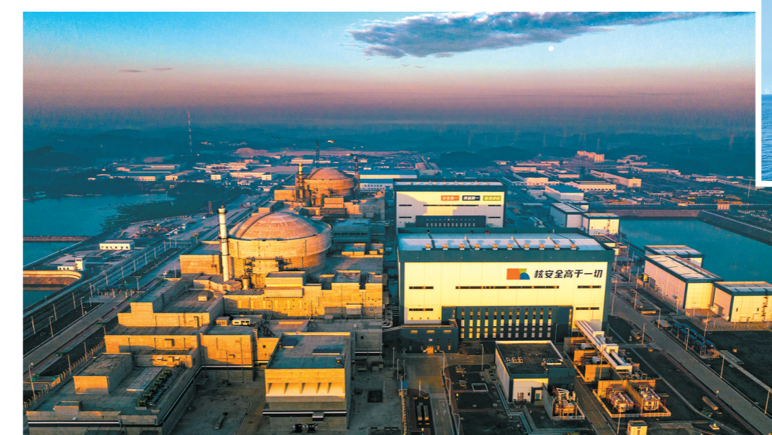
中广核“华龙一号”示范工程——广西防城港核电站二期项目
