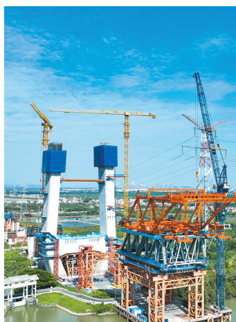
深江高铁洪奇沥水道公铁大桥主桥49号主塔施工突破百米
