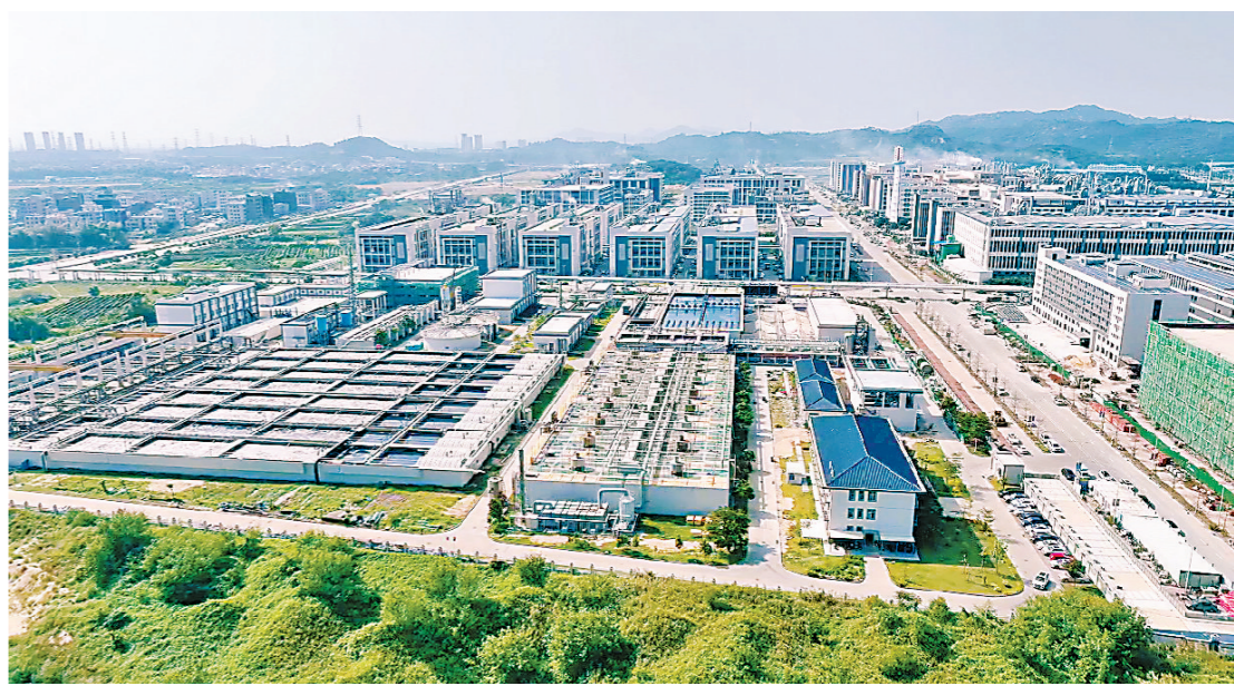
潮阳区印染园污水处理厂
