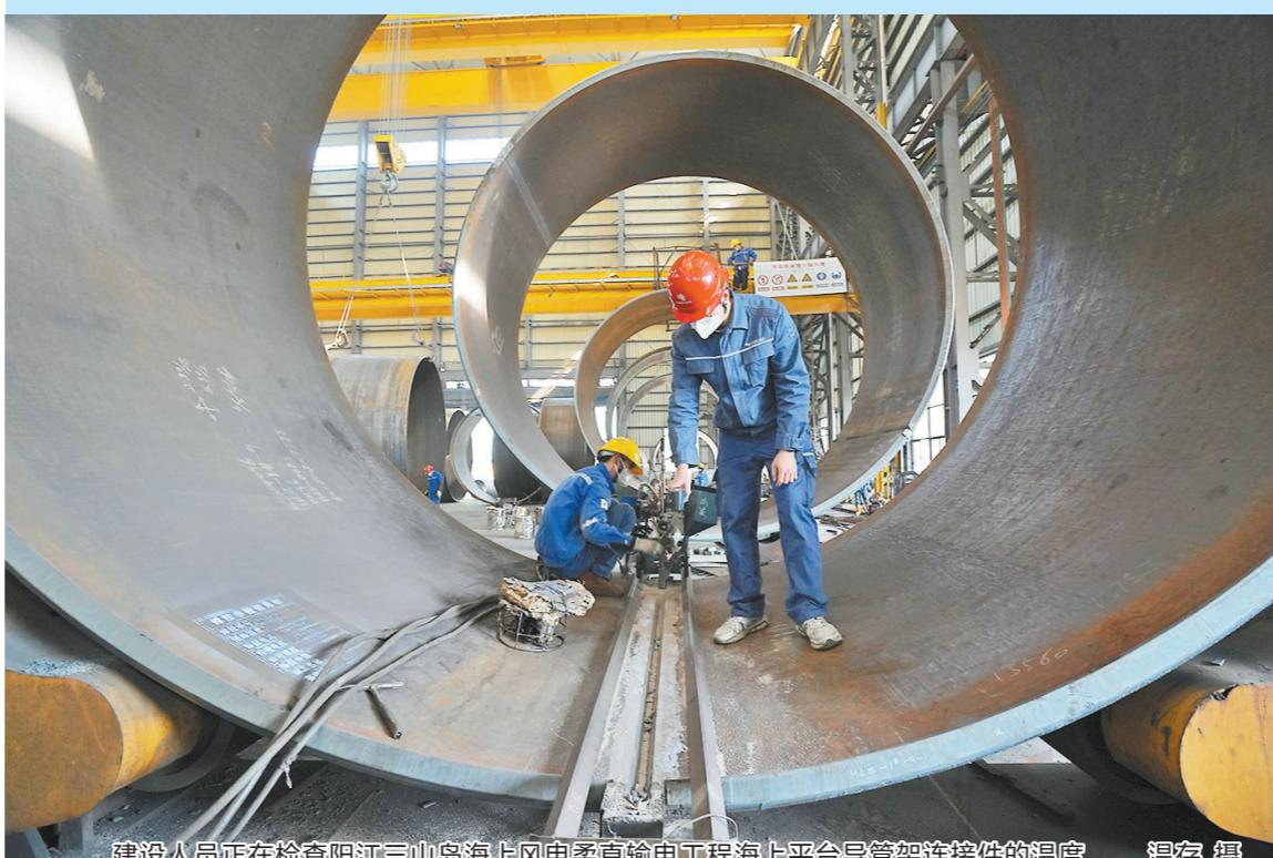
建设人员正在检查阳江三山岛海上风电柔直输电工程海上平台导管架连接件的温度 温存 摄
