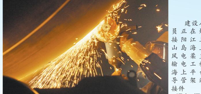
建设人员正在焊接阳江三山岛海上风电柔直输电工程平台上导管架连接件 温存 摄
