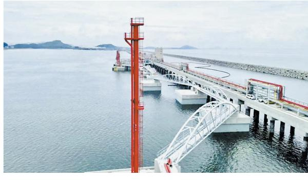
2022年11月动工建设，建1个30万吨级原油码头及其配套设施，泊位长度404米，可满足30万吨级超大型油轮全天候靠泊需求，同时兼顾5万吨级以上油轮停靠。
