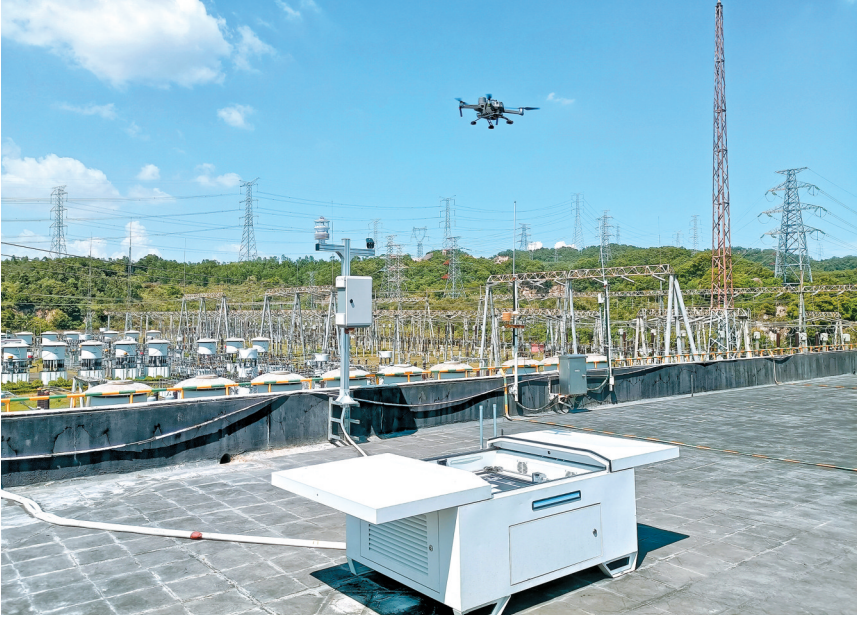
近日,南方电网广东东莞供电局应用无人机机巢开展自动巡检
