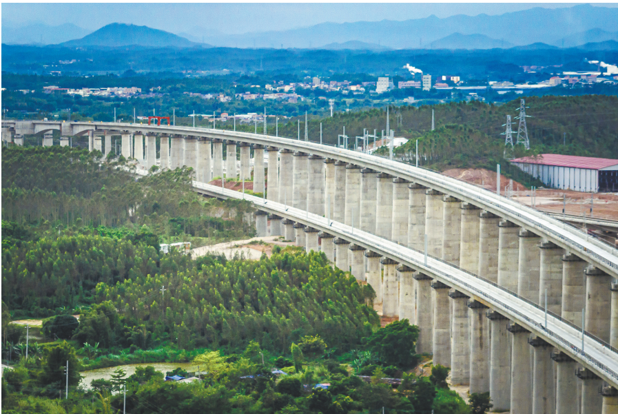
箱梁架设完成的珠肇高铁江机段7标左线回龙特大桥与右线明城特大桥
