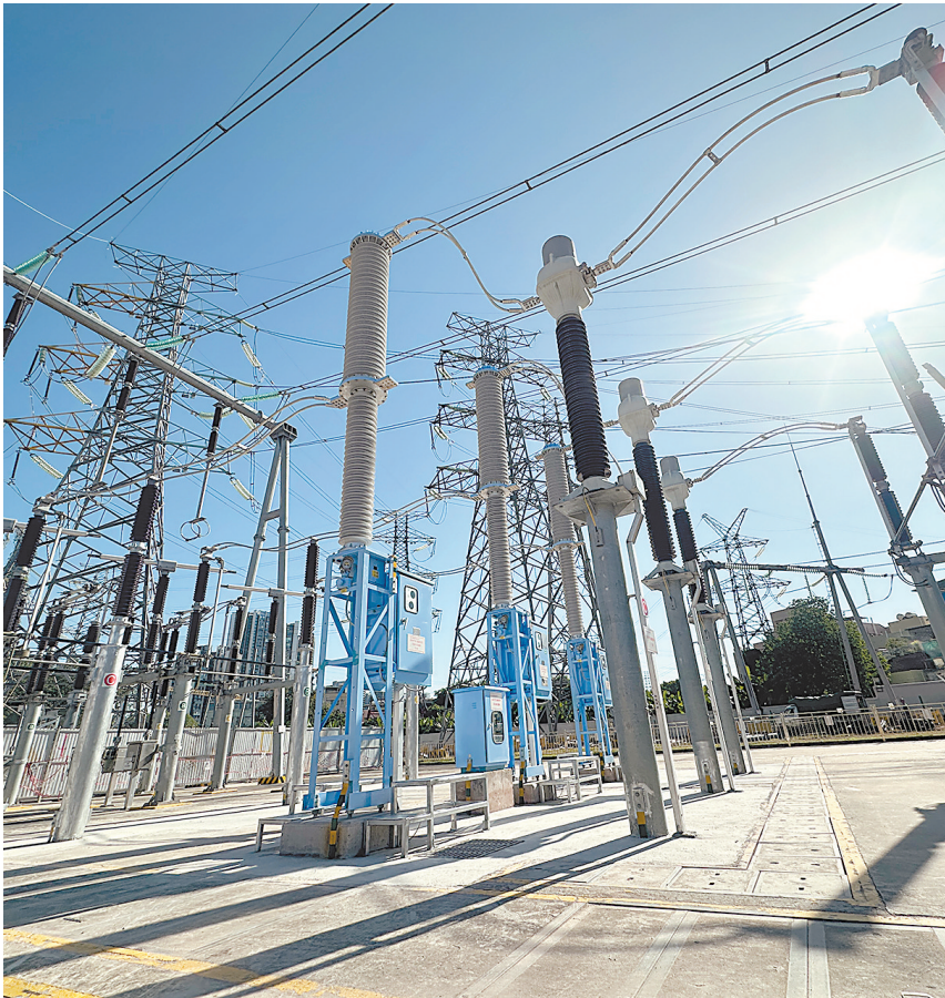
世界首台 252 千伏单断口真空断路器成功研制
