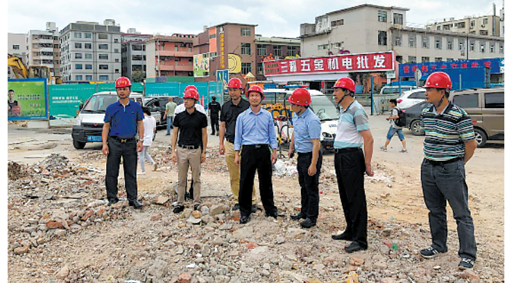
山厦河沿线房屋征拆工作现场
