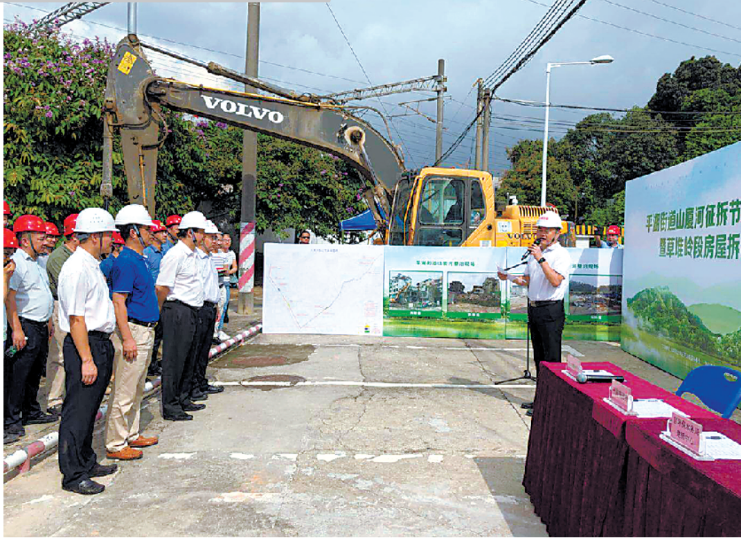
山厦河综合整治项目征拆节点整体移交暨草堆岭段房屋拆除仪式(李上彪/摄)
