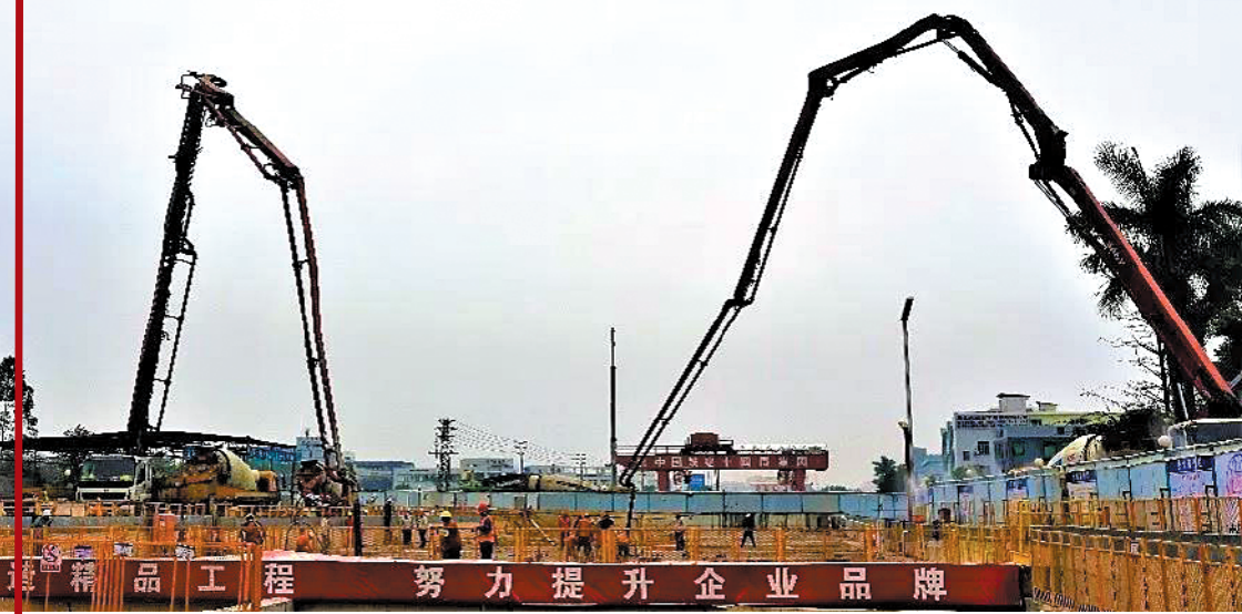
最后一模顶板浇筑
