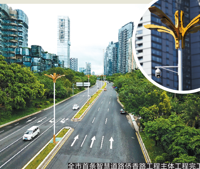
全市首条智慧道路侨香路工程主体工程完工
