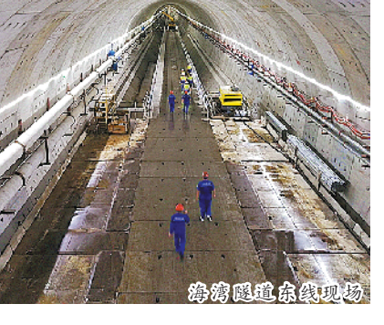
海湾隧道东线现场
