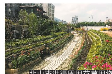
生态环保为主，兼具生态观赏性的排水明渠。该排洪渠明渠段将社区公园与北山村居隔断，美人蕉、黄金叶等植物郁郁葱葱。如今，北山排洪渠已完成下游“百米示范段”，上游正热火朝天地施工。目前，北山排洪渠水生态环境趋向好转。全段清淤1542.7米、总清淤量约4694立方米，施工完成生态铺设及绿化310米，上游截污井9座。总体工程形象进度90%，计划11月底完成暗渠截污和明渠上游截污改造。
