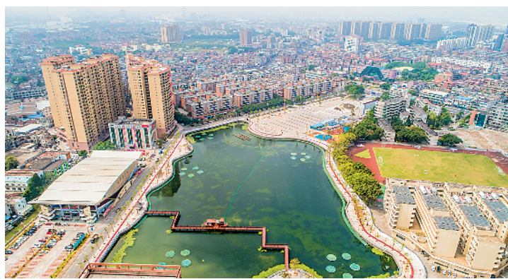
中堂镇已经完成的镇文化广场及景观湖综合提升工程
