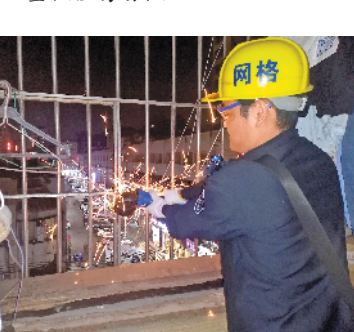
网格员现场切割开启逃生窗
