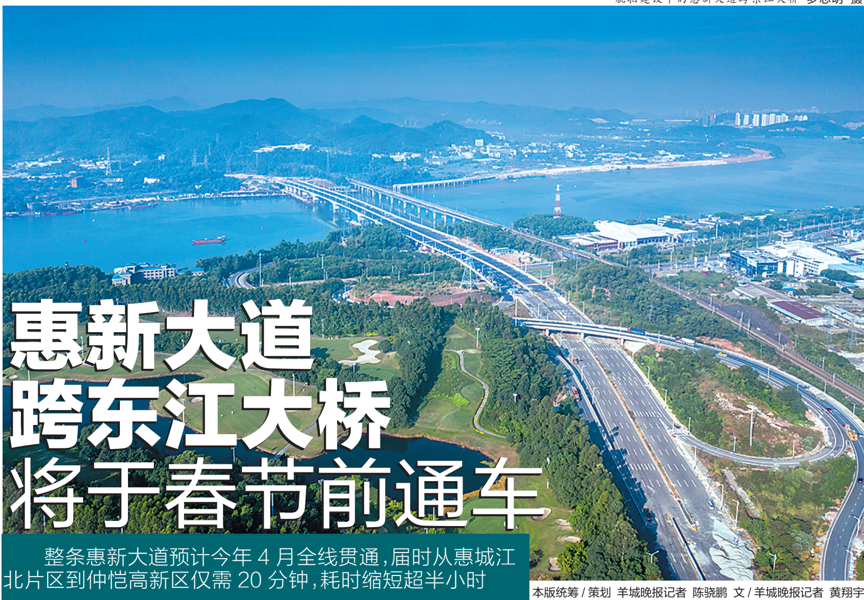
航拍建设中的惠新大道跨东江大桥 罗志明 摄
