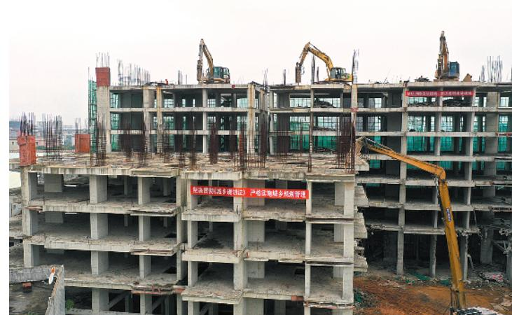
拆除现场，数台挖掘机被吊上楼顶进行拆除作业
