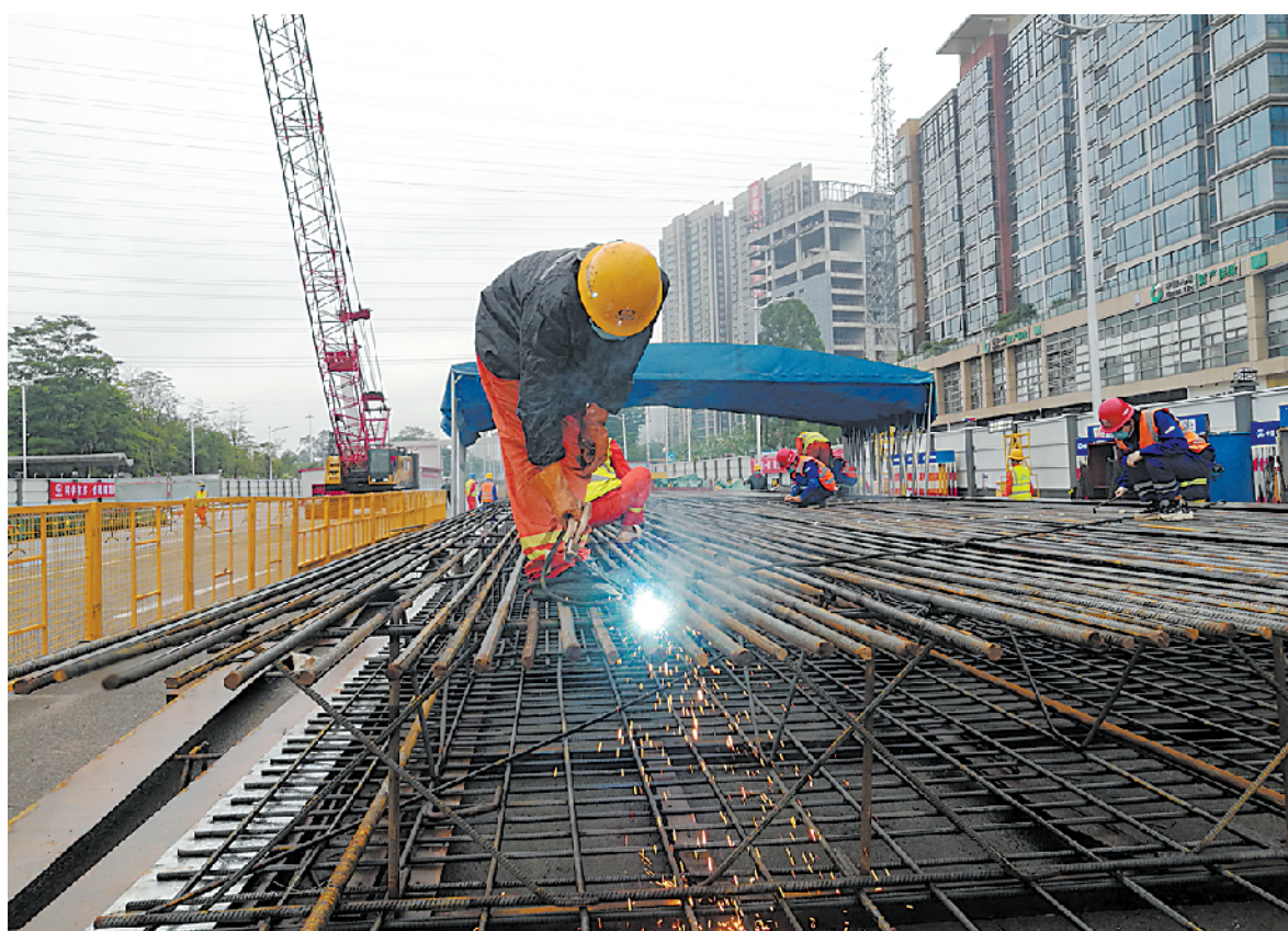
1 号线新源路项目工地
