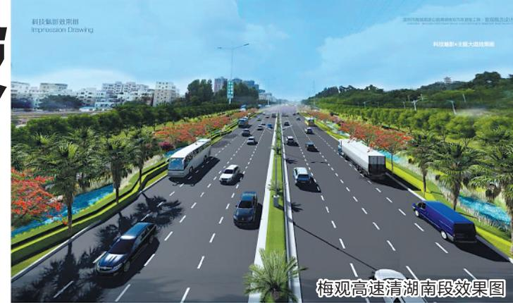
车道主路，设计速度80公里/小时，双向6车道辅路，设计速度40公里/小时，同时设置7处互通式立交，新增9座人行天桥。项目还将与皇岗路对接，同时增设多个匝道和出入口，会大大缓解华为、富士康等片区交通出行压力。此外项目充分引入海绵城市、智慧交通概念，沿线景观打造也是其重点建设内容之一，改造后的梅观路有望成为深圳中轴线上类似“深南大道”的景观大道。
