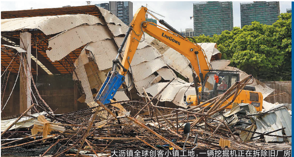
大沥镇全球创客小镇工地，一辆挖掘机正在拆除旧厂房
