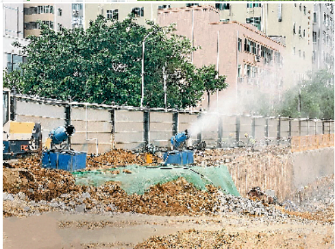
雾炮机正在进行洒水抑尘作业
