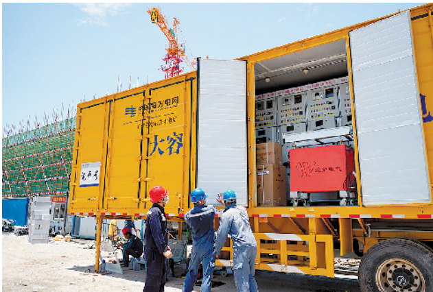
首座 移动式变 电站安 装现 场
