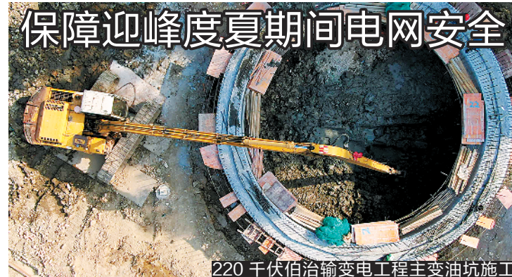
220千伏伯治输变电工程主变油坑施工
