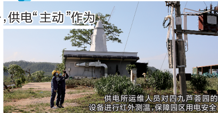
供电所运维人员对四九芦荟园的设备进行红外测温,保障园区用电安全
