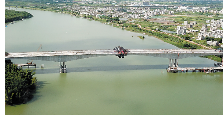
潮汕环线高速公路项目控制性工程韩江东特大桥主汉桥顺利合龙
