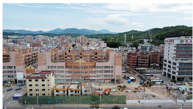
挖掘机开展拆楼工作
