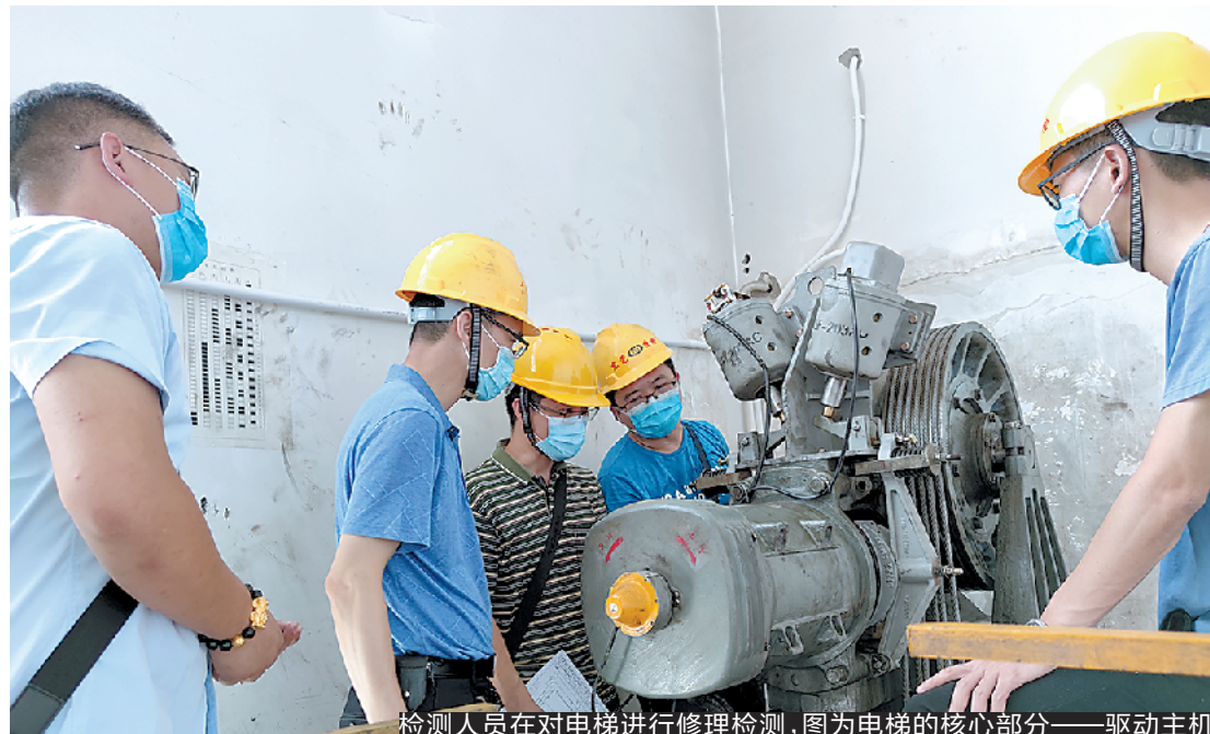
检测人员在对电梯进行修理检测，图为电梯的核心部分——驱动主机
