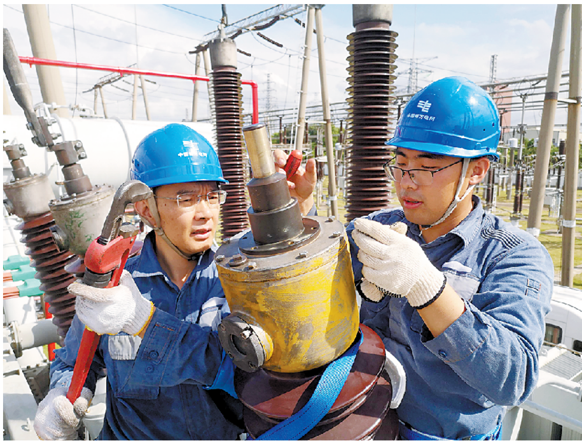
东莞供电局变电管理一所工作人员对变电站主变套管进行发热处理 李智斌 摄
