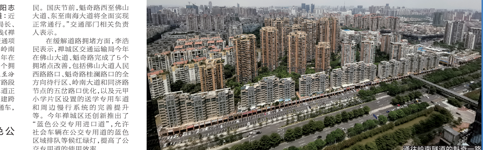
通往岭南隧道的魁奇一路
