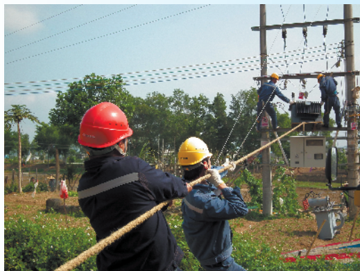
江门供电局运行维护人员正在对辖区的过载(超载)配变进行更换
