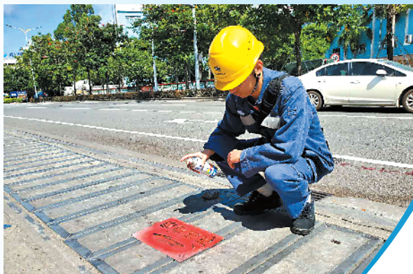
供电人员在某建设工程现场为易受外力破坏的电力设施标识电缆位置和走向 吕琳 摄
