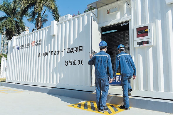
“多站合一”项目采用集装箱式的数据中心 黄志伟 摄
