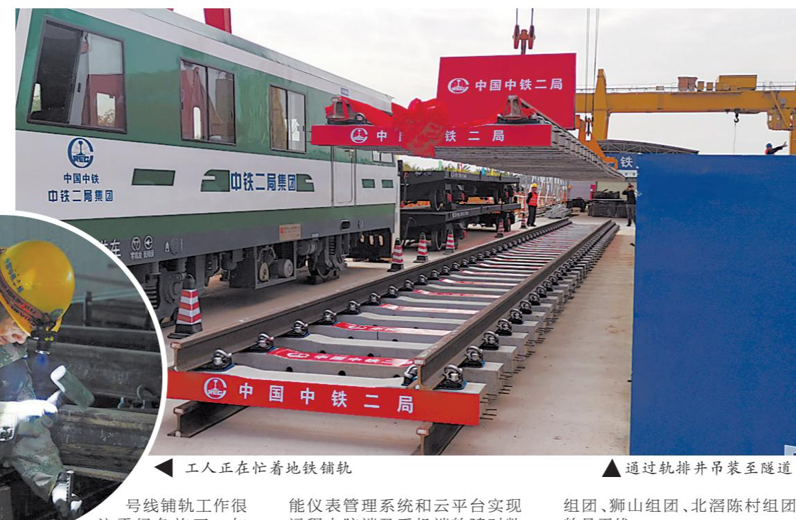
号线铺轨工作很注重绿色施工。如何从根本上解决决由柴油机尾气造成的空气污染,改善隧道施工环境?据施工单位介绍,三号线铺轨采用了低噪音、零排放、节能环保的纯电动轨道车,该车具有实时采集整车行驶状态数据和在线监测功能,通过智
