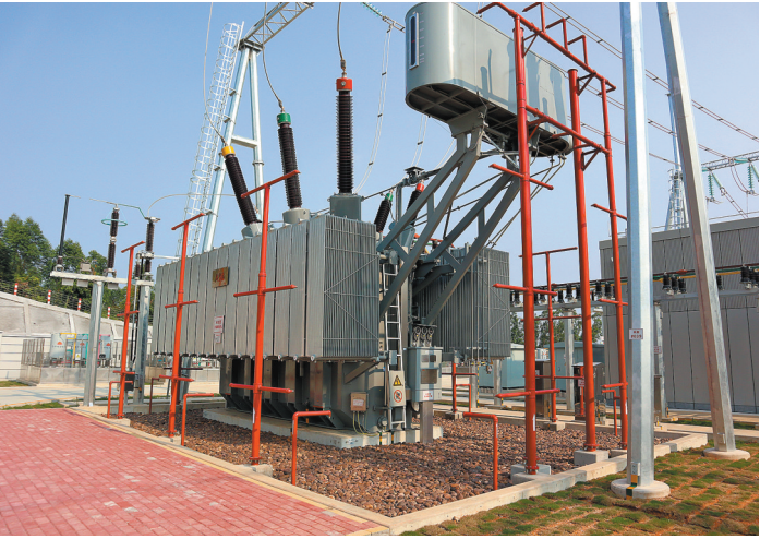
主变压器及附件安装牢固、美观
