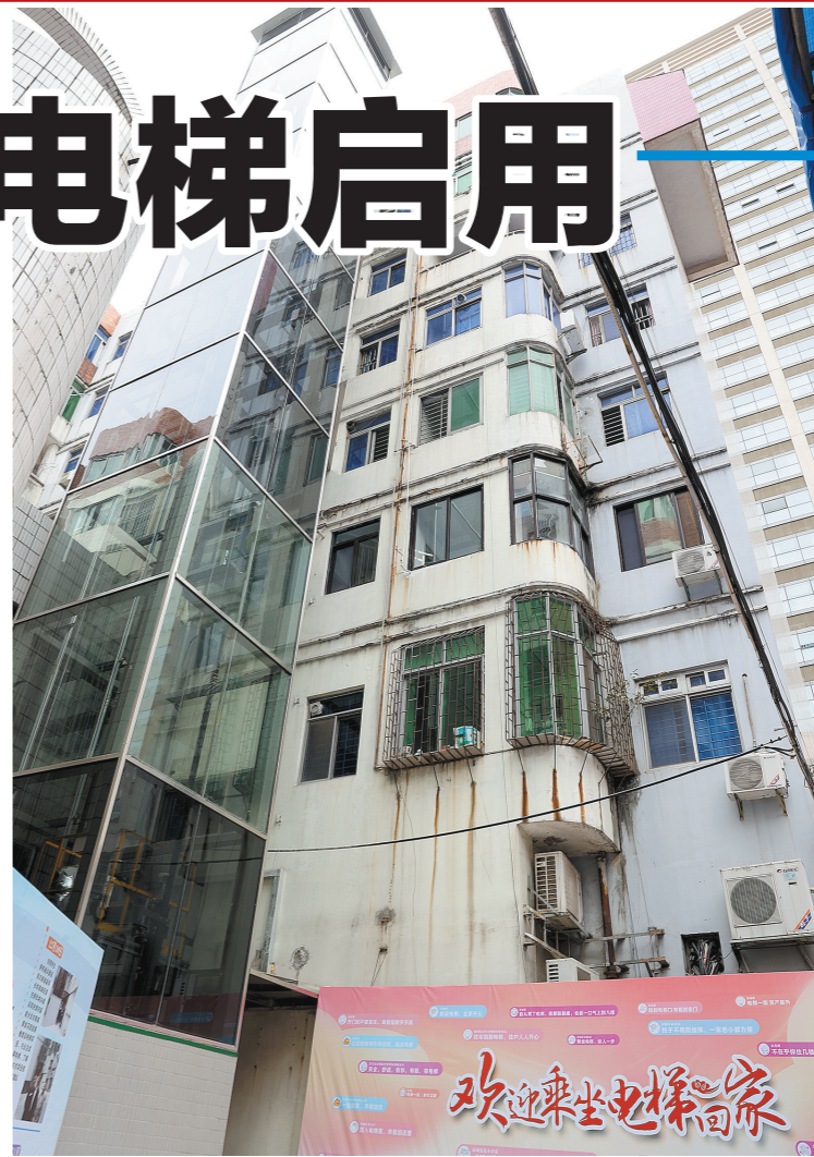
电梯采取了梯外加建模式，通过连廊连接上下半层楼梯
