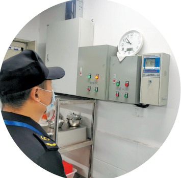
安装在厨房墙上的燃气浓度报警器 通讯员供图
