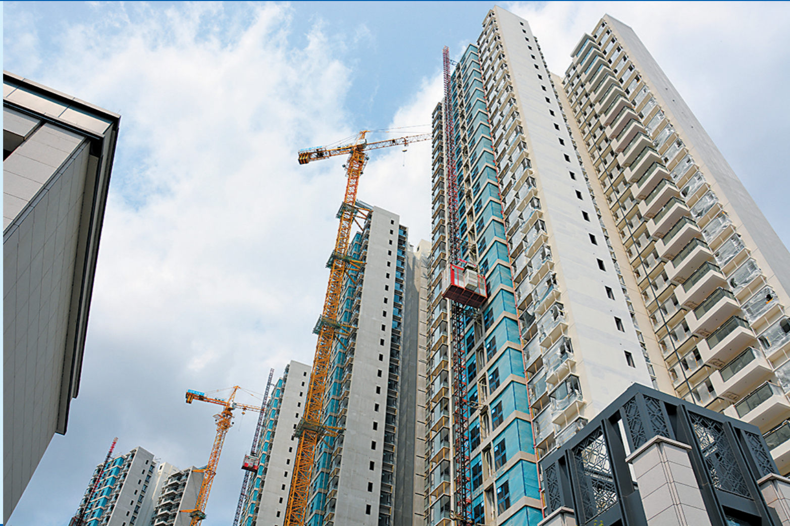
部分楼盘加快施工进度
