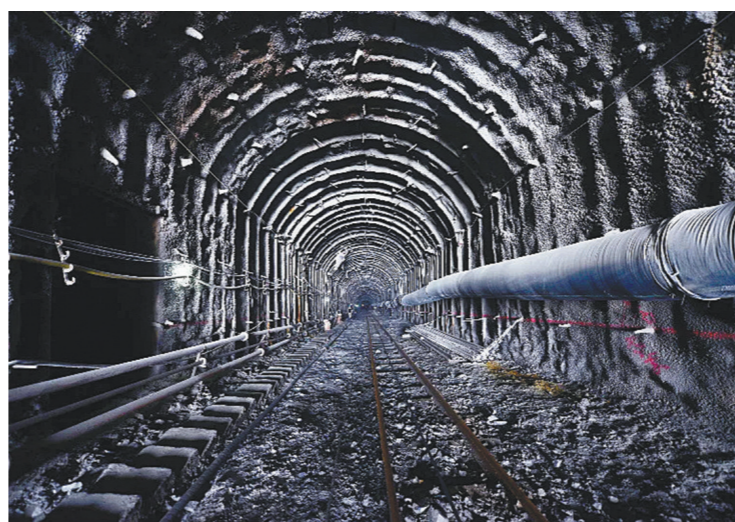
江门中微子实验室项目建设现场 刘悦湘 摄
