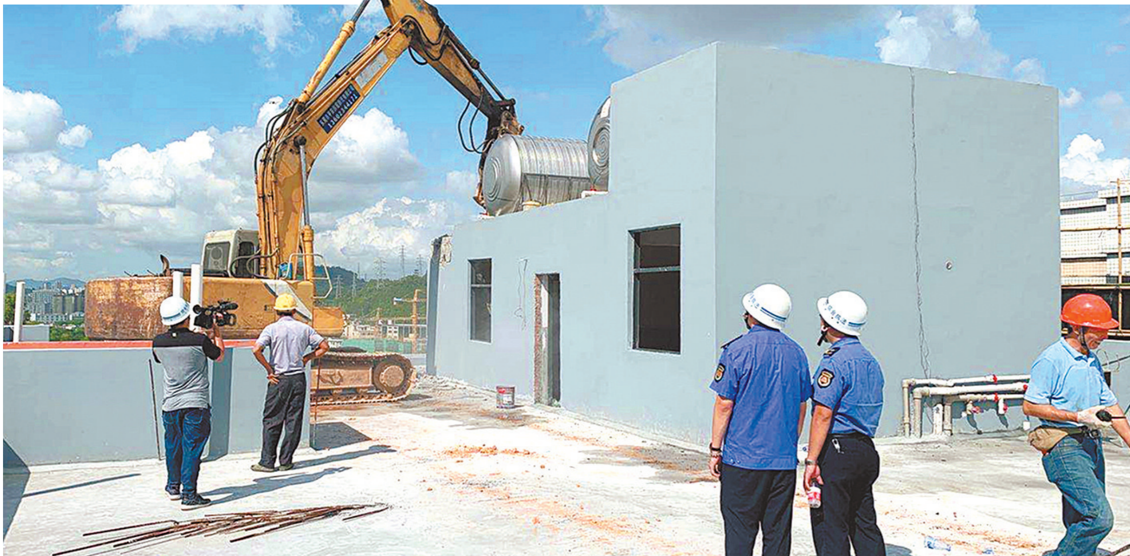
东莞城管局凤岗分局依法拆除辖区内一处违建
