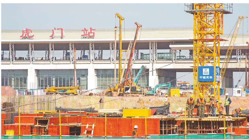
热火朝天的虎门高铁站TOD综合开发项目工地 王敬新 摄
