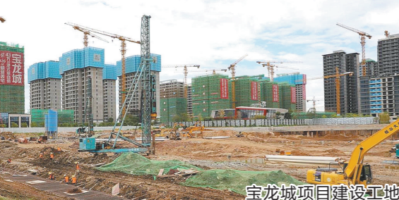
宝龙城项目建设工地
