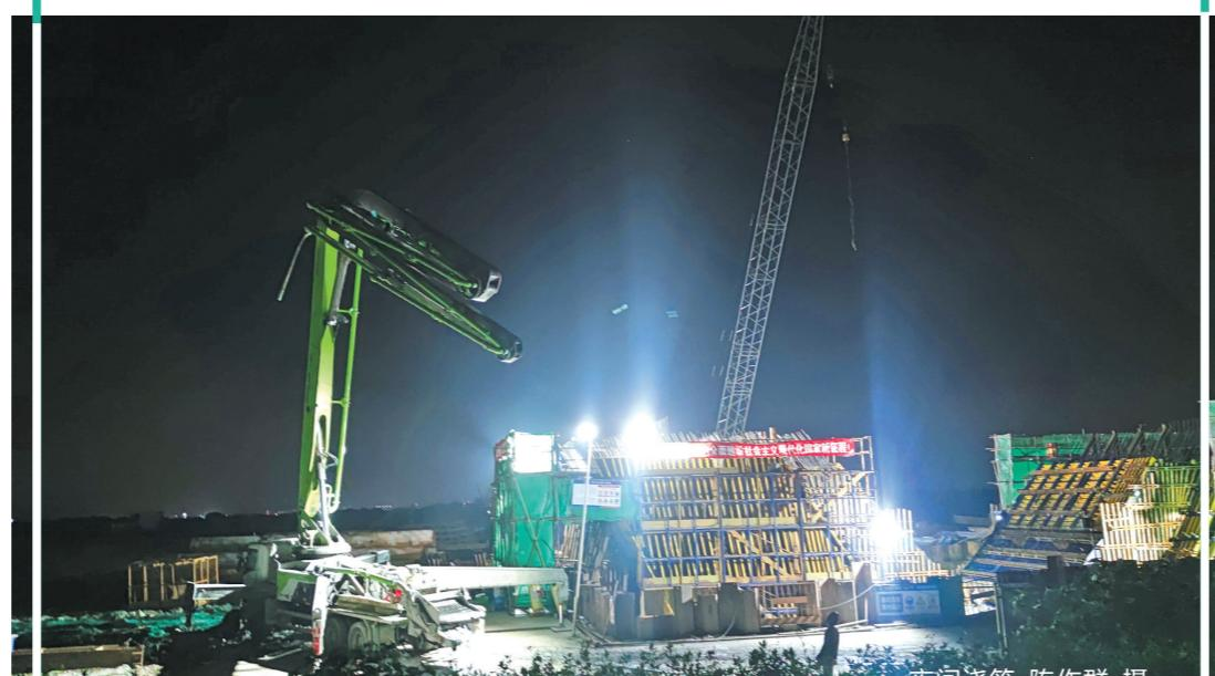
羊城晚报讯 记者林翎,通讯员陈欣、王峰、陈作群报道:7月1日,历时35个小时,由中铁大桥局承建的南中高速公路洪奇门特大桥18号主墩深基坑水上承台顺利浇筑完成,标志着洪奇门特大桥主桥东西侧主塔基础施工全部完成。而6月30日23时,该桥19号主塔首节段顺利浇筑完成,西塔“木棉花”率先“破土而出”。
